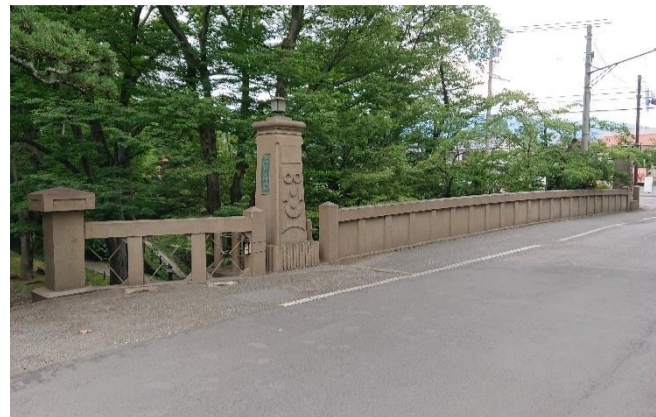
↑ ②-2 真田傍陽線 二の丸橋 (橋上の欄干ほか)
