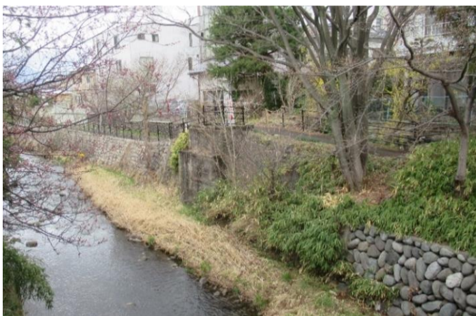
↑ ④ 真田傍陽線 矢出沢川橋梁の橋台跡 (1) (下紺屋町公会堂付近の矢出沢川)
