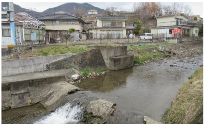
↑ ⑥ 真田傍陽線 矢出沢川橋梁の橋台跡 (2) (国道18号線沿い、矢出沢川上流側)
